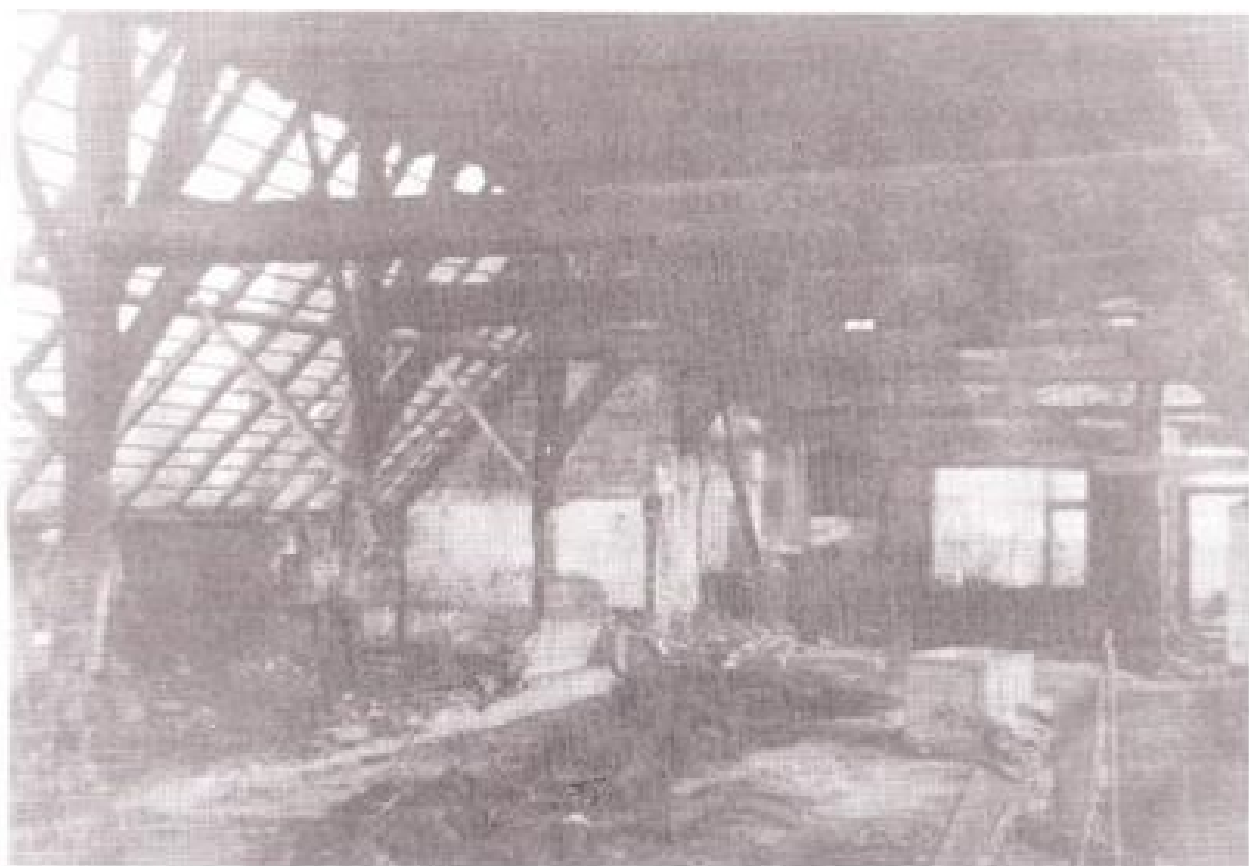
Zware eikenbalken hebben het bouwwerk 270 jaar overeind gehouden tot het in 1976 werd afgebroken. (foto: G. Derksen)
