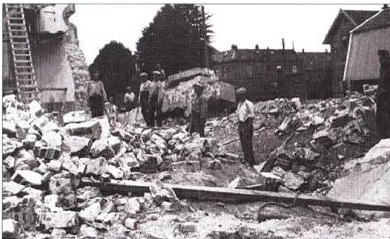
Foto 4 De sloop van het neogotische duarschip in mei/juni 1932. Let op de primitieve en gevaarlijke manier van werken - coll. Hist. Kring.
