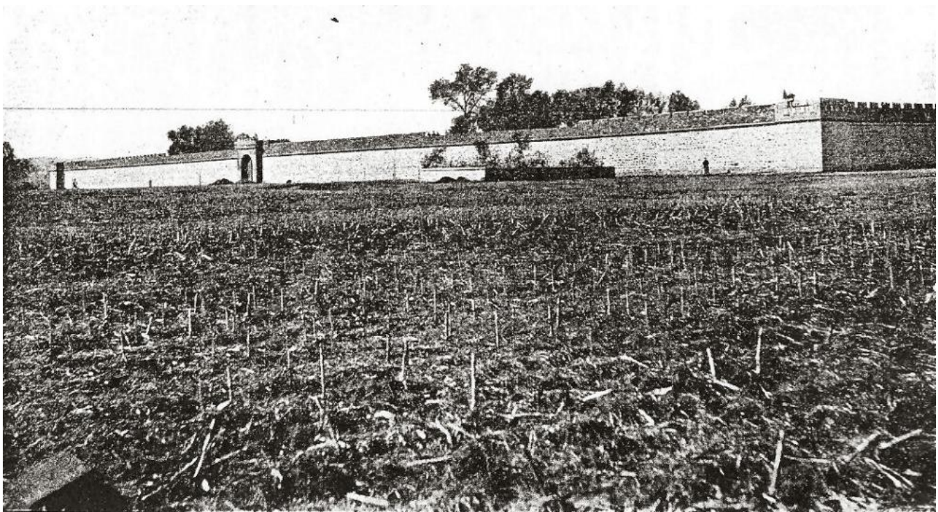
RINGMUUR OM DE RESIDENTIE VAN MGR. ABELS, O. L. V. TER PIJNBOOMEN. (Buitenzicht.)
