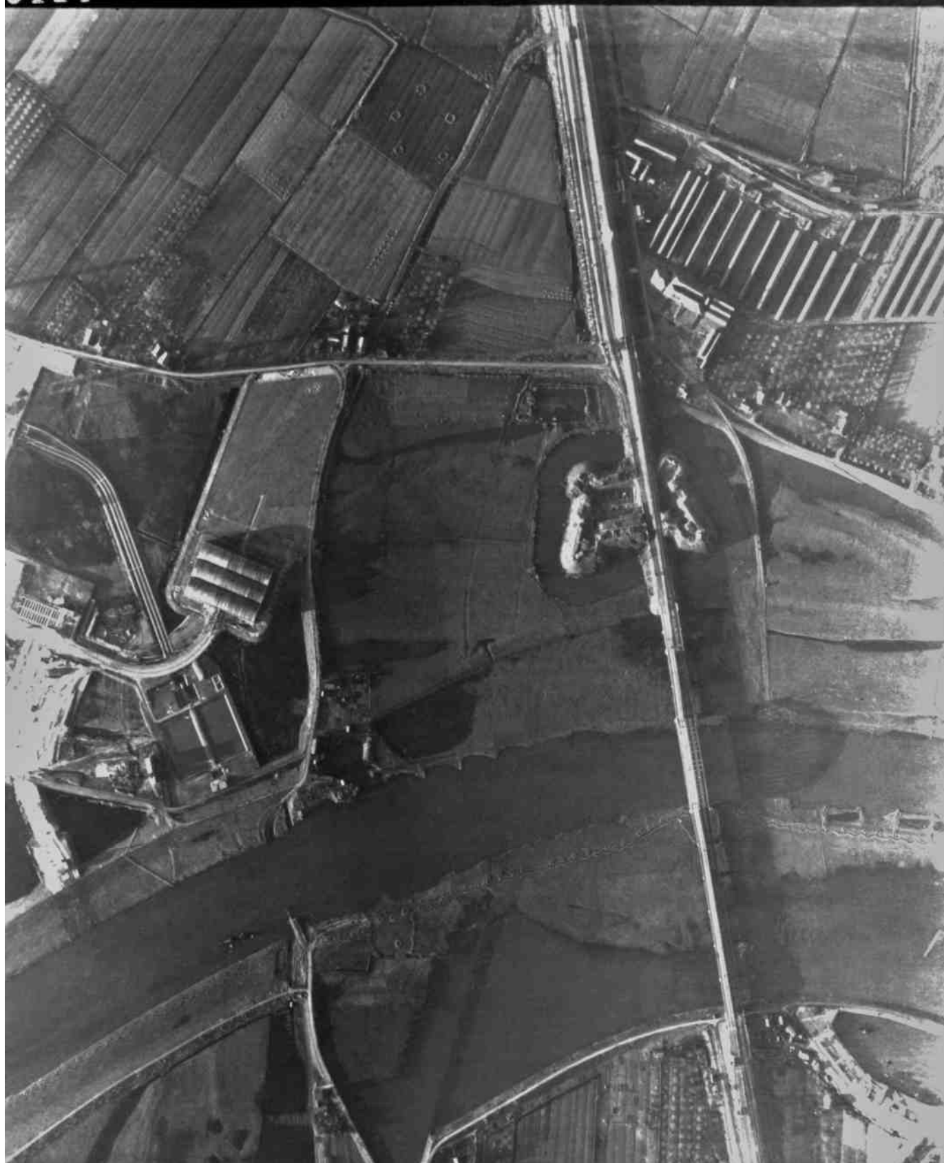
Luchtfoto van Westervoort, genomen op 21 november 1944. De oversteek plaats voor de Buffalo's lag tussen de brug en de
