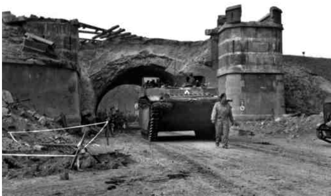
Een Buffalo van het A eskadron rijdt onder het vernielde spoorviaduct de Dorpstraat in. (National Archive Canada, PA132580)
