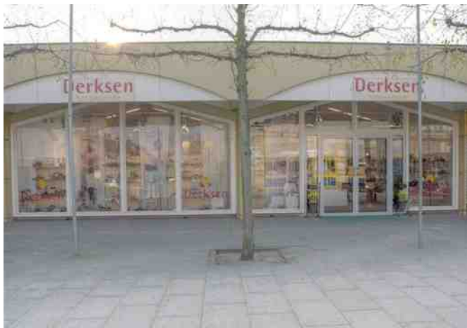
Het voormalige winkelpand aan de Pastoriestraat in Duiven
