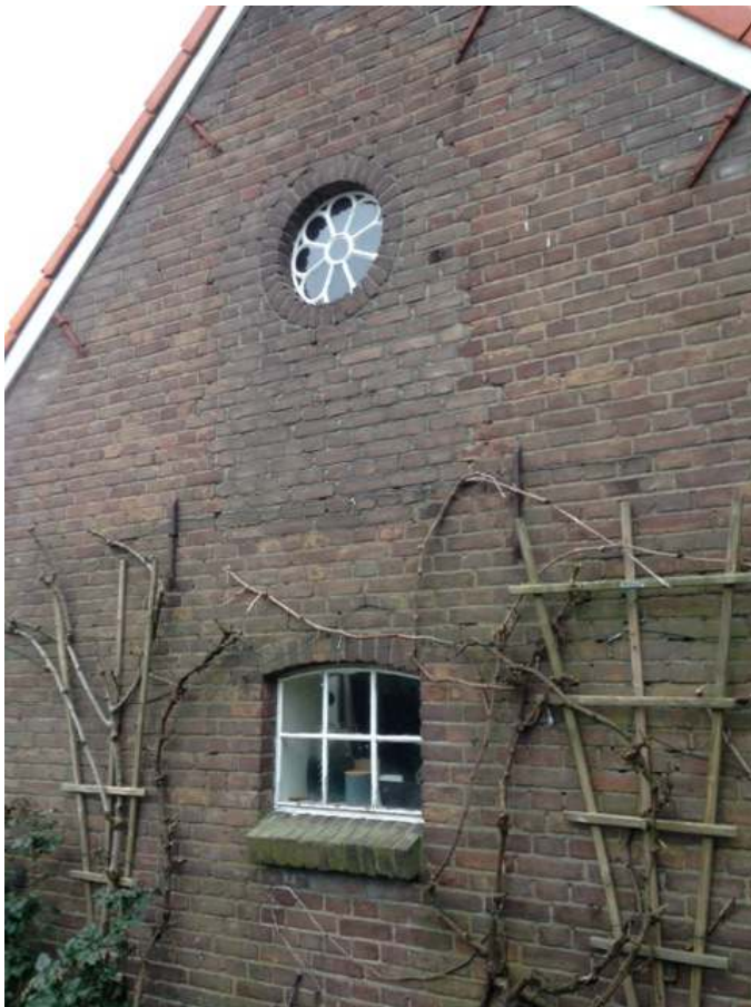
De opgebouwde varkensstal waarop nog steeds de herstelwerkzaamheden te zien zijn.
